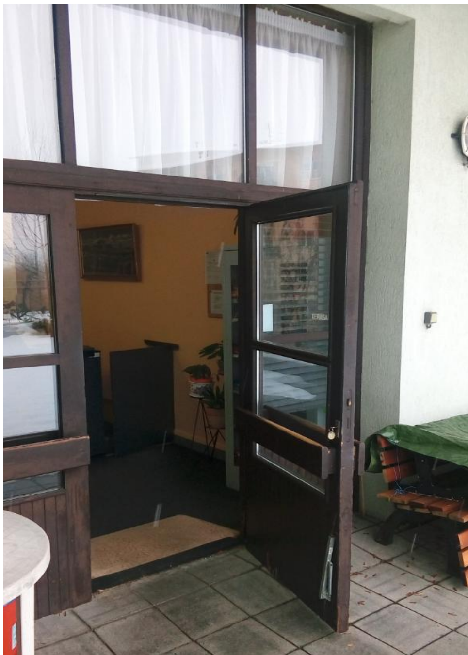
2) Exteriér-TERASA. Prosklená stěna s dvoukřídlými dveřmi, která je zabudovaná ve stavebním otvoru rozměrů cca 3600mm x 3100 mm a která je vysklená izolačními dvojskly. Bude šetrně rozebrána a předána investorovi.
