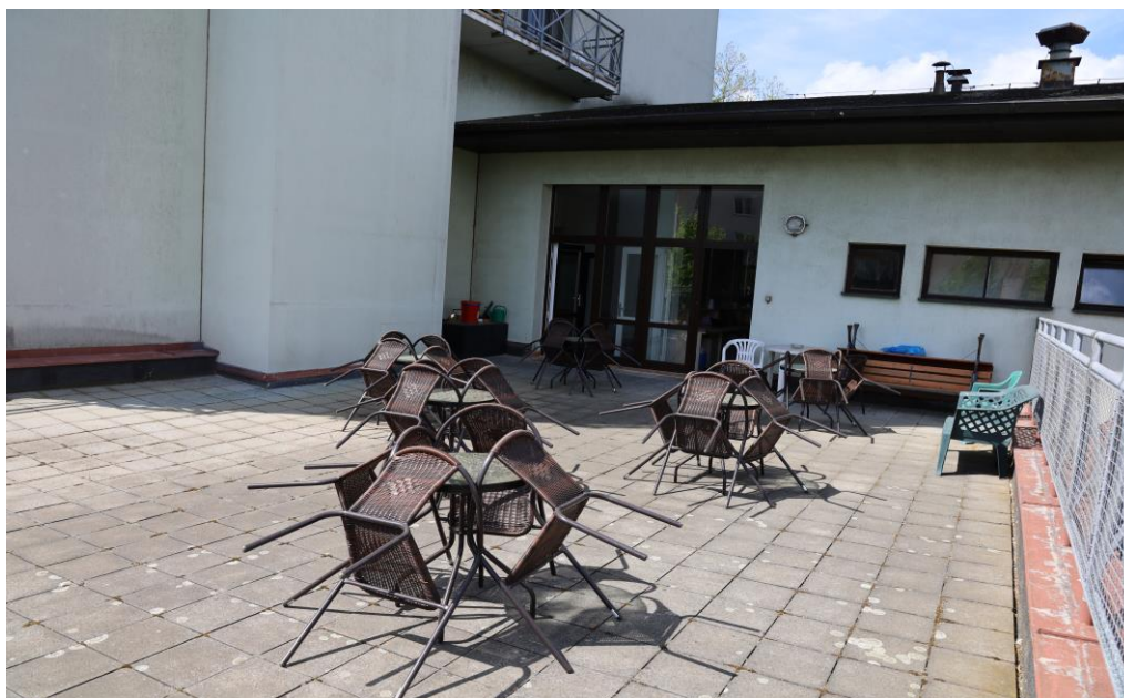
Stávající venkovní terasa
